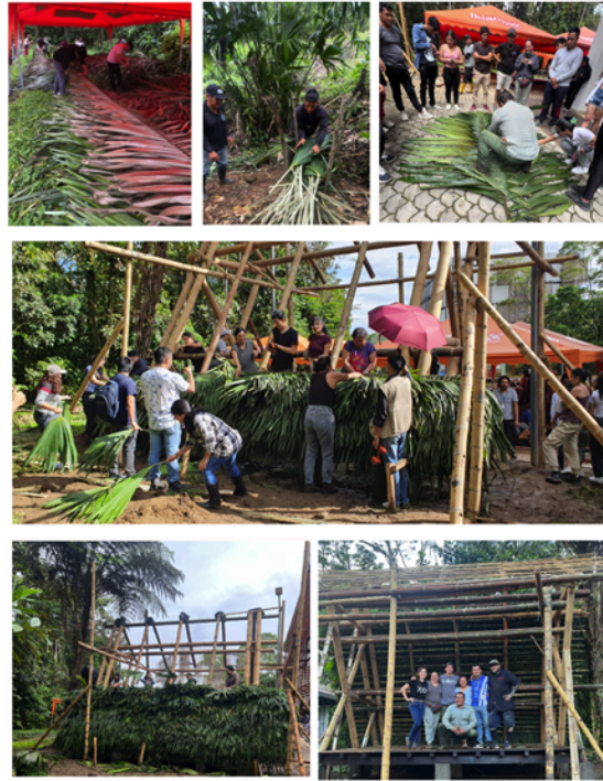
Figura 3. Proceso de recolección de hojas, apilamiento construido en ikiam y tejido de cubierta del escenario.
